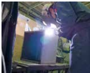
配電ボックスの溶接作業
