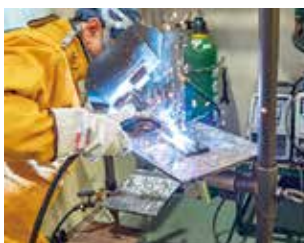
半自動アーク溶接作業
