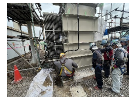
【変圧器更新工事】
