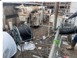
【ケーブル敷設工事】
